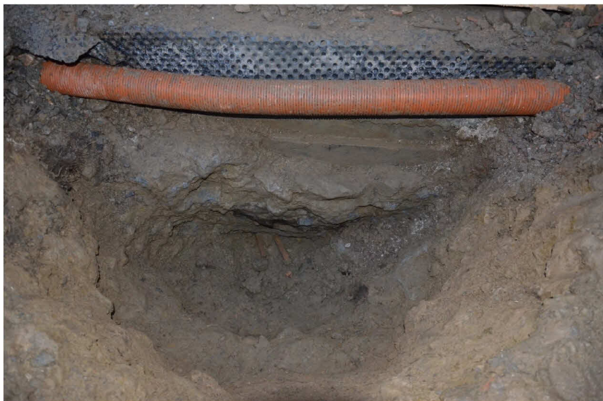
Spodná časť základu do výšky cca 60 cm z kameňa - fotografia z nariadenej sondy
